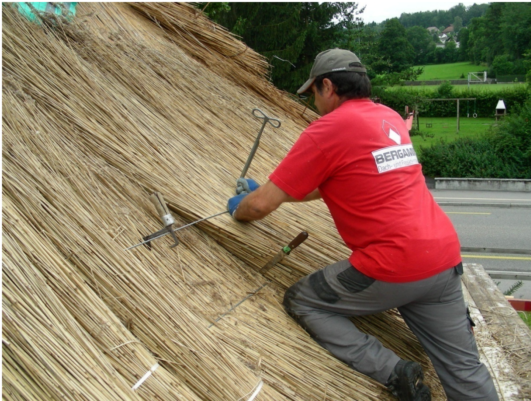
Strohdachsanieierung im Sommer 2012
